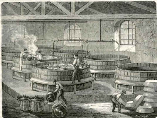
Fig. 51. — Cuves pour la saponification du suif par la chaux.
