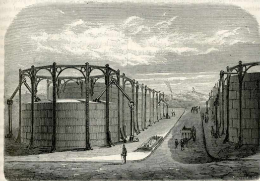
Fig. 76. — Les douze gazomètres de l'usine de la Villette.
