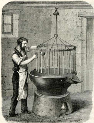
Fig. 47. — Fabrication des chandelles à la baguette.
