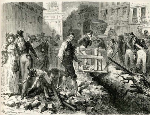
Fig. 67. — Impressions des Parisiens devant les premiers travaux pour la pose des conduites de gaz dans les rues.
